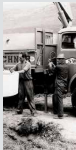
1963 Herstellung der ersten biologischen Kläranlage
